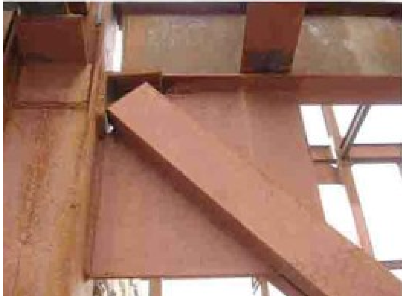
شکل (۹-۴) اتصال مهاربندی با ایجاد خط آزاد خمش
