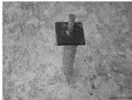
نصب فلنج رو سر هر میکروپایل
