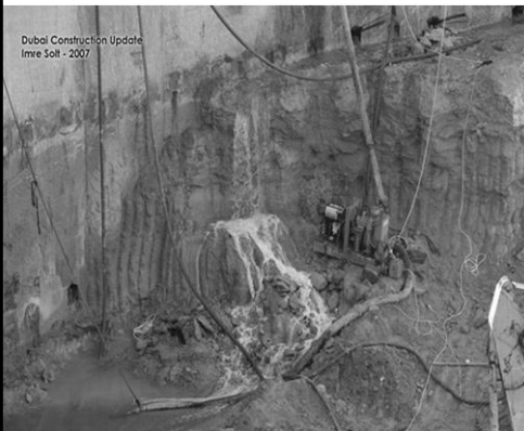
مشکلات حفاری و برخورد با نشت آب
