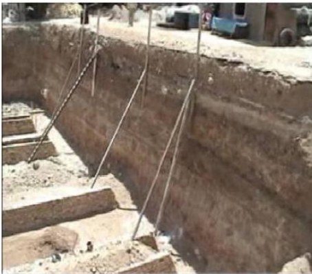
(ب) گودبرداری و سازه نگهدارنده غیر اصولی
