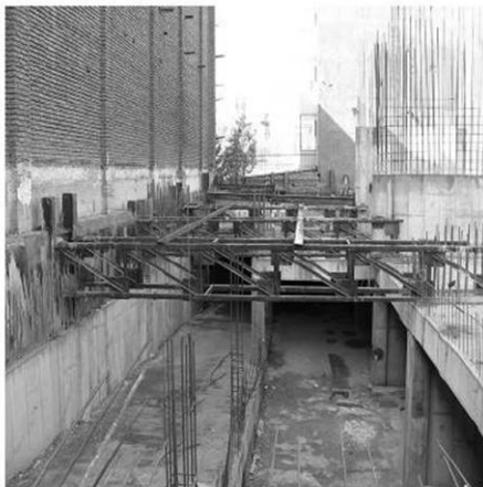
(ب) نمونه‌ای از مهار متقابل در گودبرداری
