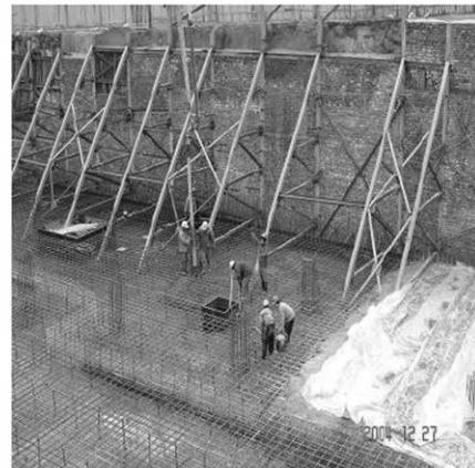
(الف) خریای مورب با دیوار آجری بین خریاها
