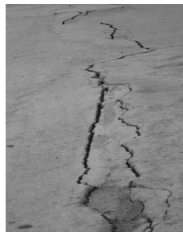
پایش ترک در کف حیاط یا کف زیرزمین
