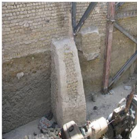
(ب) اجرای سازه نگهدار غیراصولی (منبری) و نشست ساختمان‌های مجاور
