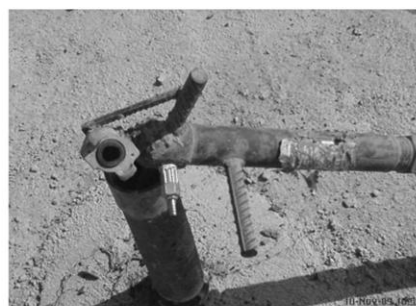
نصب پکر و تجهیزات تزریق روی لوله های کوبیده شده
