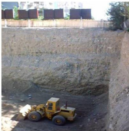
(الف) گودبرداری غیر اصولی به صورت دیواره قائم
