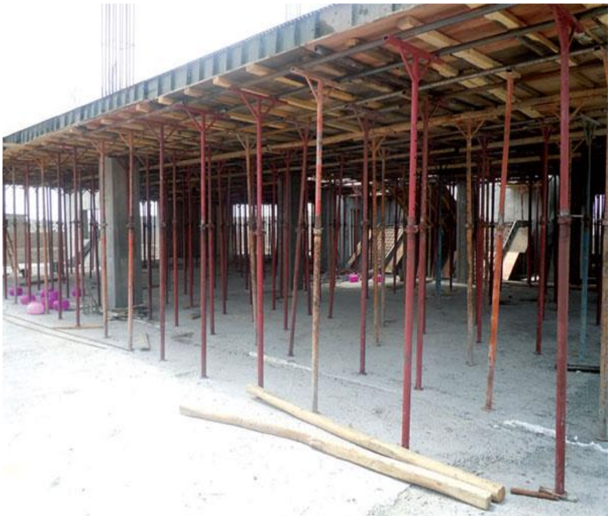
۱. قالب بندی سقف
