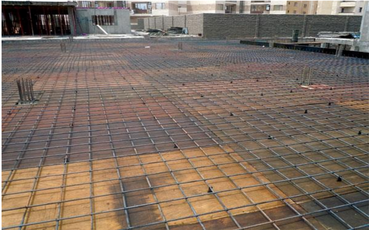
۲. اجرای شبکه آرماتور پايینی
