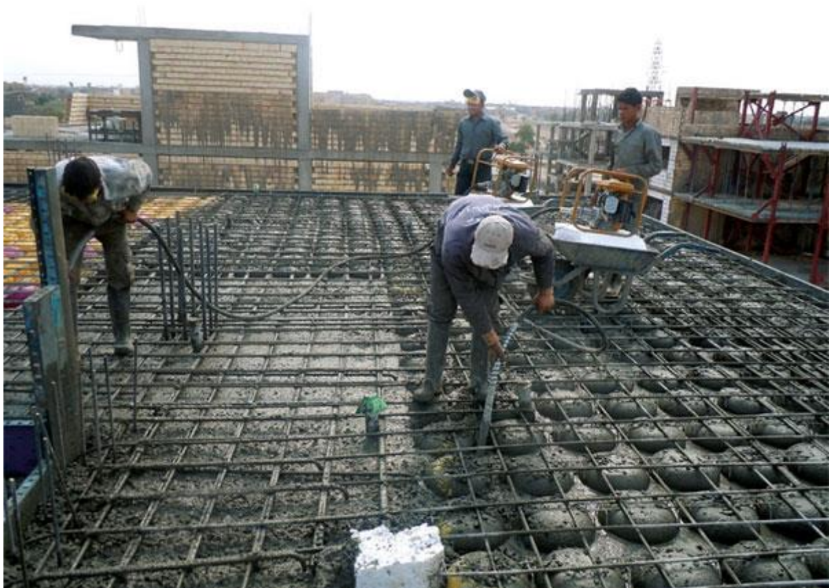
۵. بتن ریزی و ویبره زدن
