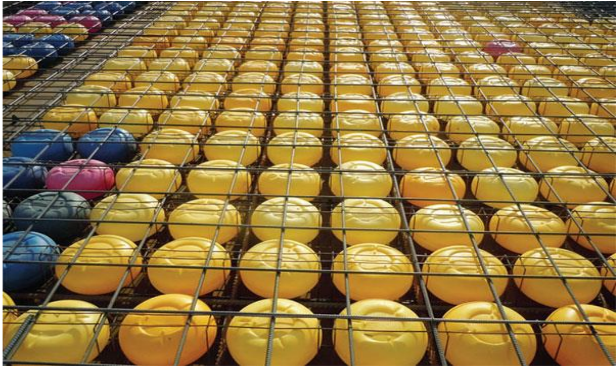
۴. اجرای شبکه آرماتور بالایی
