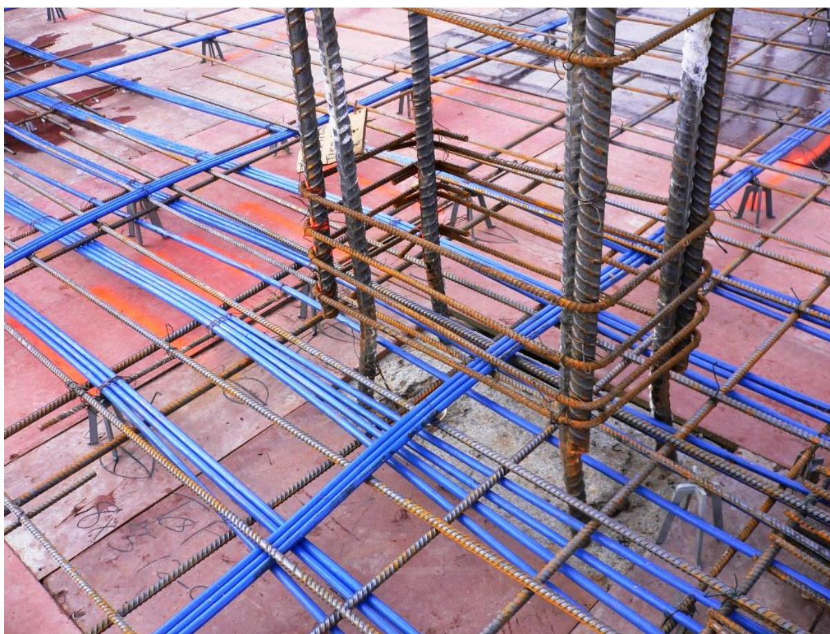
سقف دال بتن (بتن پیش تنیده)
