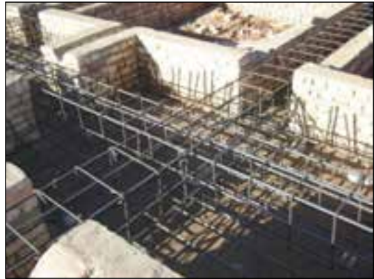
شکل ۳-۱۳۵ عبور میلگردهای شناژ در پی
