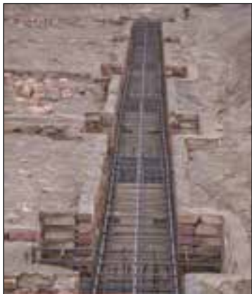
شکل ۳-۱۳۶ پی و شناژ قبل از بتن ریزی
