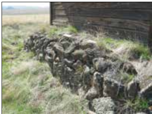
شکل ۳-۴۰ پی سنگی با سنگ لاشه
