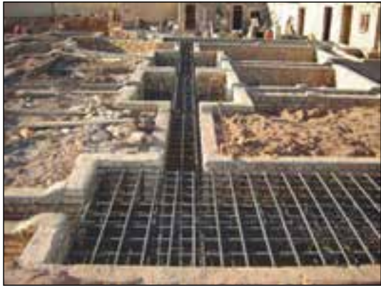
شکل ۳-۱۳۴ میلگردگذاری در پی کلاف بندی
