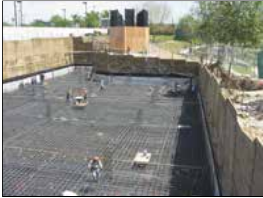
شکل ۳-۶۸ پی بتن مسلح یکپارچه (رادیه ژنرال)
