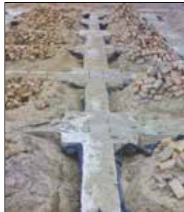
شکل ۳-۱۳۷ پی و شناژ بعد از بتن ریزی
