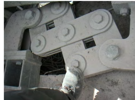
استفاده از میراگر اصطکاکی دورانی در کارخانه سیمان
