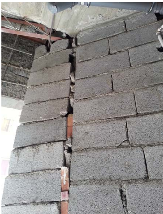
شکل ۷- عدم هشتی مناسب تیغه به سقف و عدم گیری و اتصال صحیح بین دو دیوار
