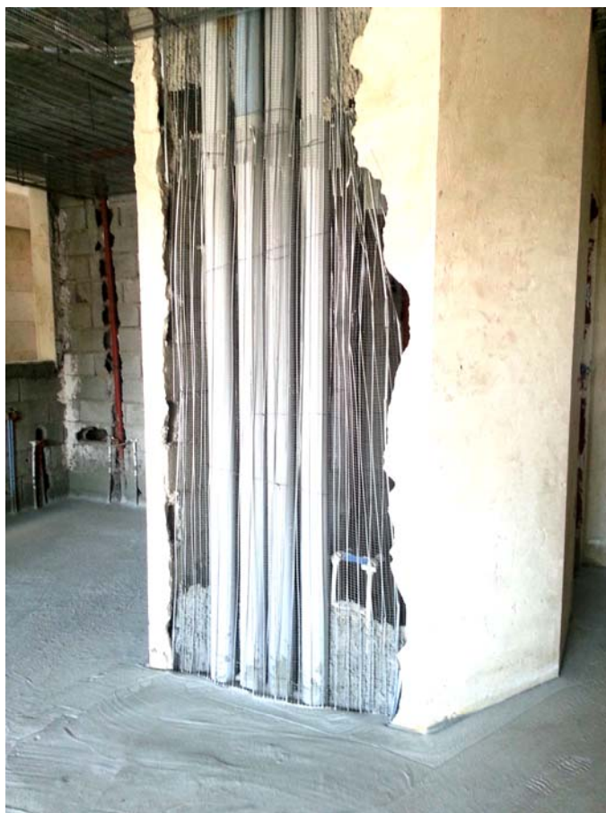
شکل ۱۱- تخریب دیوارها جهت عبور لوله های تاسیساتی
