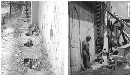
(ب) نصب پروفیل‌ها و بتن ریزی
