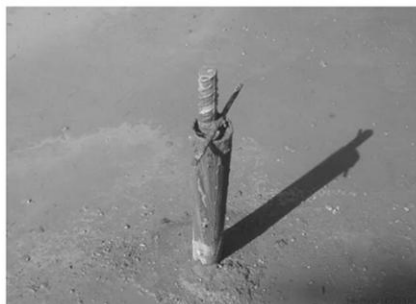
انجام تزریق و فرورودن میلگرد تسلیح در لوله
