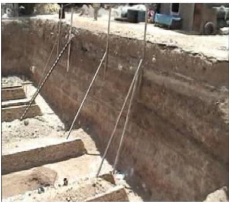
(ب) گودبرداری و سازه نگهدارنده غیر اصولی
