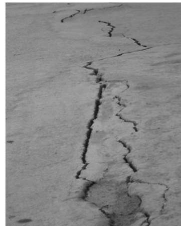
پایش ترک در کف حیاط یا کف زیرزمین
