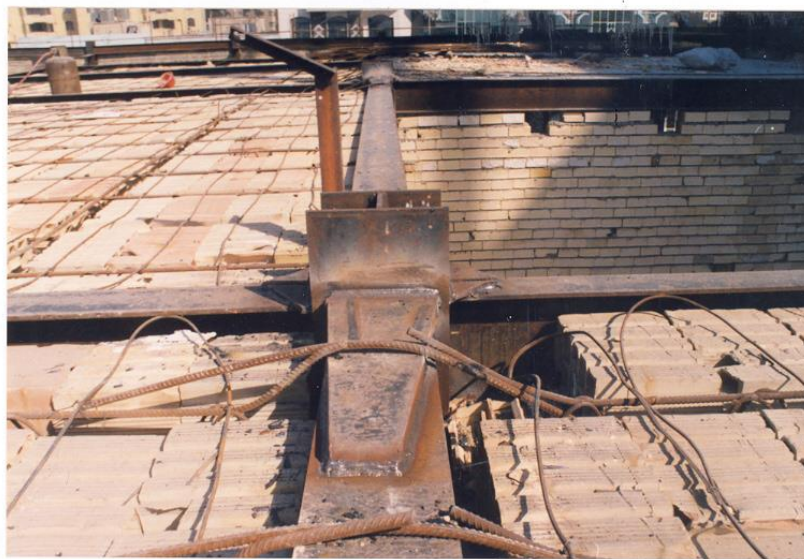
وضعیت جوش اتصالات بعد از اجرای طرح تقویت و بهسازی
