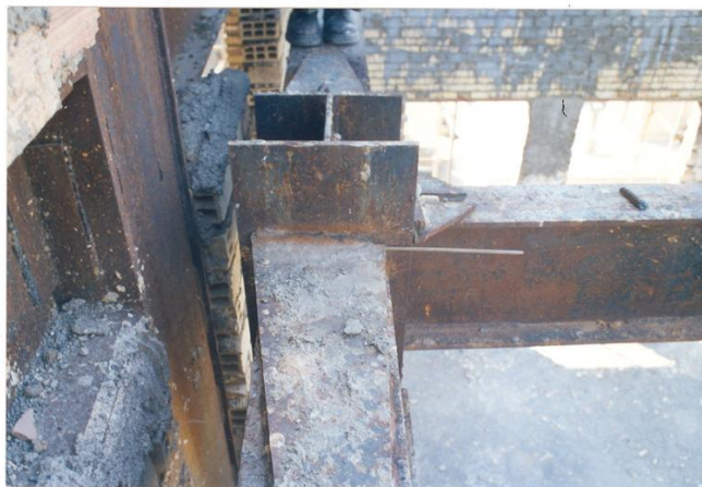
وضعیت جوش اتصالات قبل از اجرای طرح تقویت و بهسازی
