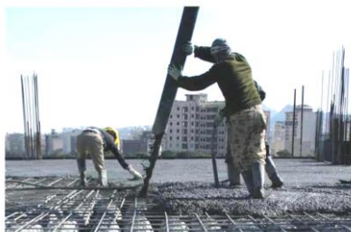
بتن ریزی و ویبره
