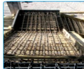
شکل ۷-۳۵- اجرای میلگردهای تال پله
