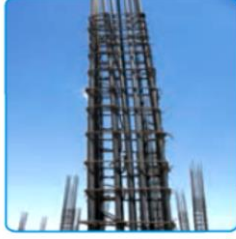
شکل ۱۹-۷- کار گذاشتن میگرد های انتظار ستون در فرمناسیون
