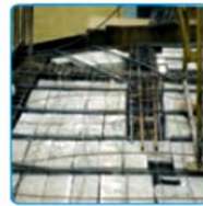
شکل ۷-۳۲- اجرای تیرهای قرعی کنسول
