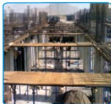
شکل ۷-۲۱- قاب بندی تیرها
