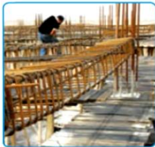
شکل ۷-۲۴- تنظیم فاصله بین خاموت ها
