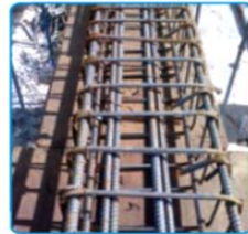
شکل ۷-۲۵- بستن خاموت ها با مفتول
