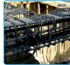
شکل ۷-۲۶- جعبه بندی میلگردهای اصلی در انتهای محل فرکانجی
