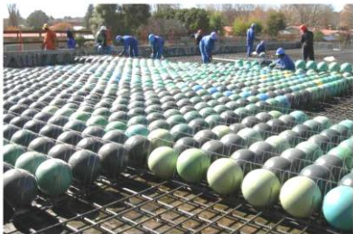
قرارگیری توپ ها بر روی مش تختانی
