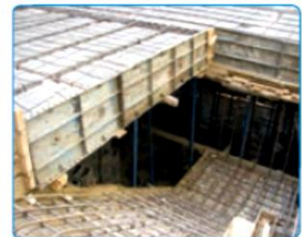
شکل ۷-۳۸- اجرای میلگردهای تال پله
