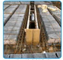
شکل ۷-۳۰- اجرای پوزشودر سقف
