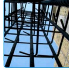
شکل ۱۹-۷- کار گذاشتن میگرد های انتظار ستون در فرمناسیون
