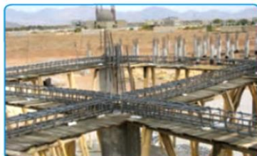
شکل ۷-۲۷- رعایت فاصله پوشش بتنی در کف
