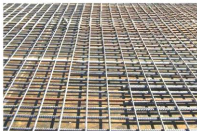
اجرای مش تختانی
