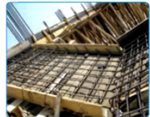
شکل ۷-۳۶- اجرای میلگردهای تال پله
