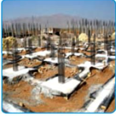
شکل ۱۷-۷- اجرای خاموت و ستیج فک
