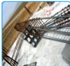
شکل ۷-۲۲- آماده کردن میلگردهای تیروی روین
