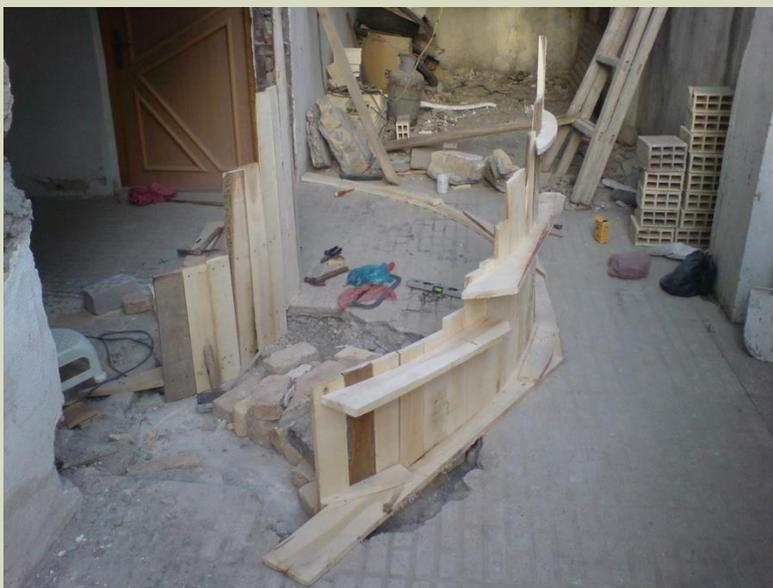
• سپس با تعیین محل شروع اولین پله (با منظور نمودن پوشش روی بتن که میزان عقب نشینی یا کد ارتفاعی کاهش یافته بخاطر نما سازی را مشخص می کند) تخته های قائم را با اندازه مناسب بریده و از قسمت پایین آن، به تخته های کوبیده بر روی زمین میخکوبی می کنیم. این تخته ها را بر روی قوس خارجی و هم قوس داخلی می کوبیم. نگران شل بودن این تخته نباشید چون پشت بند ها استحکام کافی را جهت ایستایی آن تأمین خواهد کرد. شعاع برش تخته های پشت بند، برابر شعاع تخته های است که به زمین کوبیده شده اند.
