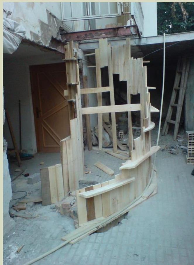
بسته به ارتفاع پله و فراخور کار، در هر مرحله که احساس کردید پایداری قالب در حال کمتر شدن است، می توانید با کوبیدن قید های افقی (در ترازى که بعداً مزاحم کارتان نشود) قالب را پایدار تر و مستحکم تر کنید. البته در نظر داشته باشید که قوس قالب نیز تا حدودی به پایداری آن کمک می کند.
