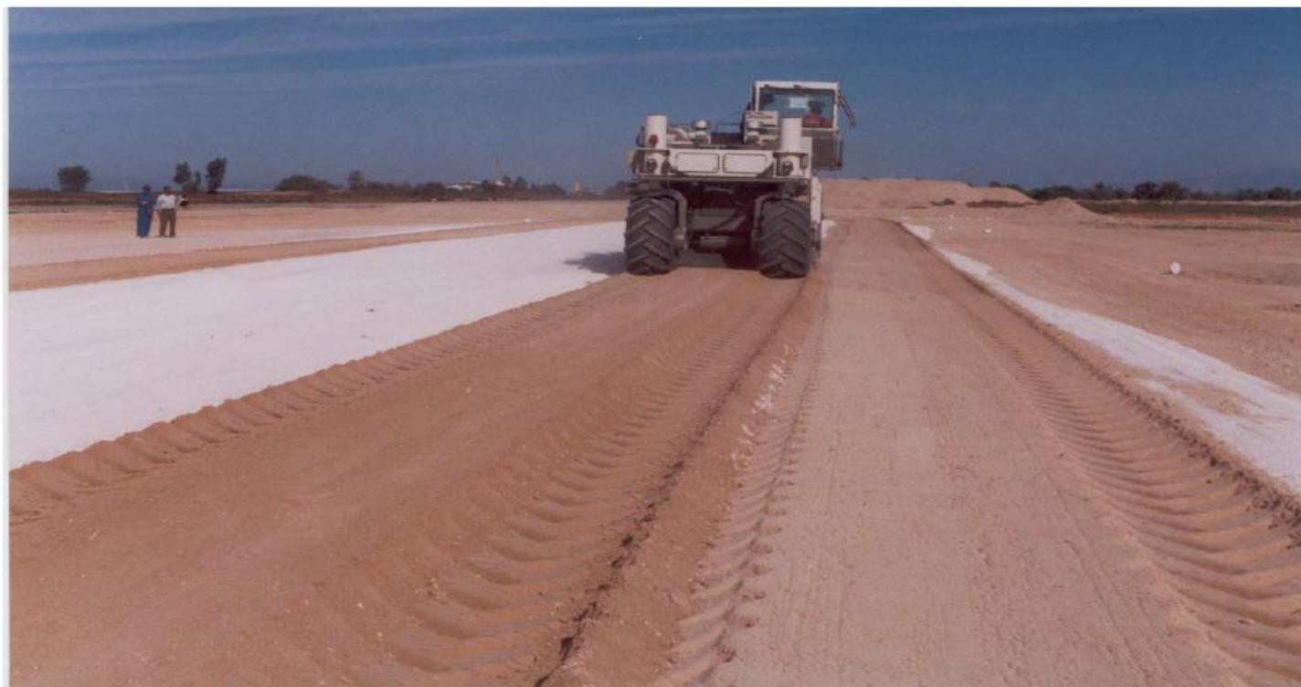
شکل ۵: عملیات تثبیت خاک با آهک بوسیله ماشین WR2500 و برتگن - فرودگاه عسلویه (آهک قبلاً روی زمین پخش شده است)
