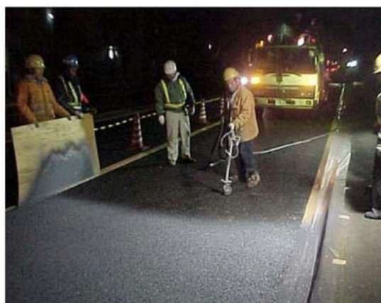
شکل ۱ استفاده از نانو ذرات \text{TiO}_2 در بتن جاده های جهت خود تمیز شونده گی و کاهش آلودگی هوا
