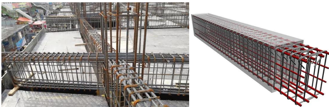
شکل ۲- تیر بتنی مسلح با میلگرد طولی و عرضی
