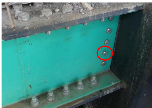
اجرای سوراخ استاندارد
