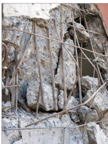
شروع خرابی از محل وصله، بعنوان یک نقطه ضعیف
