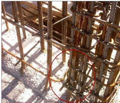
عدم مهار میلگرد دیوار در ستون
