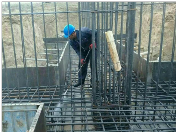
پاک کردن مواد زائد در محل بتن ریزی
