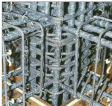
اجرای خاموت در گره اتصال
