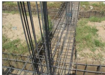
اجرای پی بدون قالب و پوشش پلاستیکی
