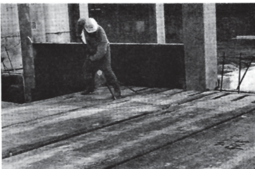
شکل ۱۰-۴ جابه جا کردن قطعات سقف به محل اصلی خودشان با استفاده از اهرم
