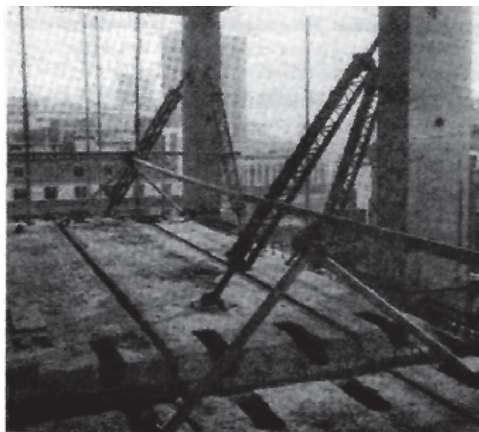
شکل ۸-۴ مهارهای کششی برای حفظ پایداری موقت ستون
