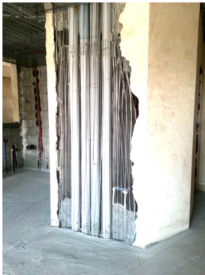
شکل ۱۱- تخریب دیوارها جهت عبور لوله های تاسیساتی
