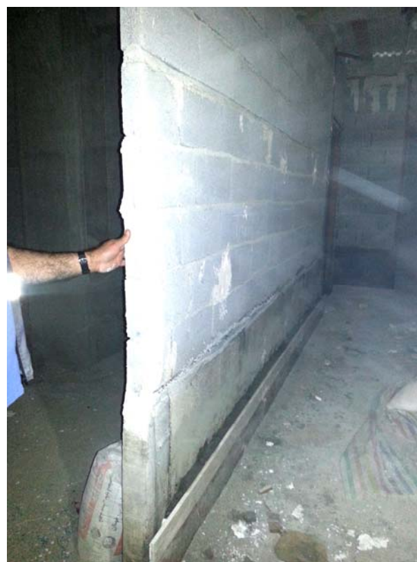
شکل ۶- عدم رعایت ضخامت دیوارهای خارجی و مجاور فضای کنترل نشده مغایرت با مبحث ۱۹
