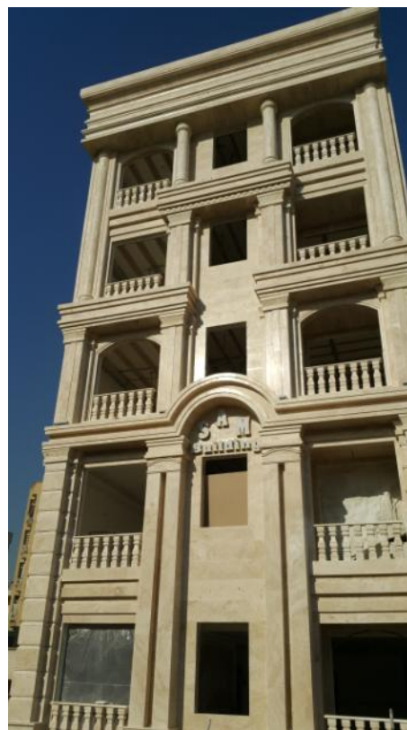
شکل ۱۵- نمای پروژه با احجام و پیش آمدگی بیش از حد مجاز و استفاده از صراحی و ایمن نبودن نرده سنگی (صراحی) نما از لحاظ ارتفاع و اتصال به سازه اصلی
