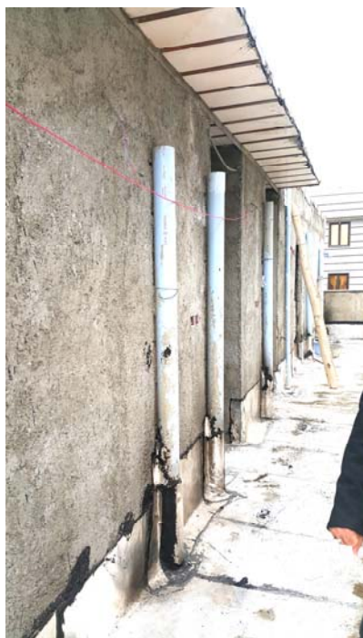
شکل ۱۲ - عدم استفاده از درپوش برای جانپناه شرقی و غربی و عدم دیوار کشی و محافظت اطراف لوله های ونت
