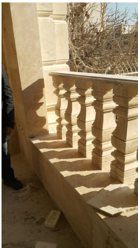
شکل ۱۵- نمای پروژه با احجام و پیش آمدگی بیش از حد مجاز و استفاده از صراحی و ایمن نبودن نرده سنگی (صراحی) نما از لحاظ ارتفاع و اتصال به سازه اصلی
