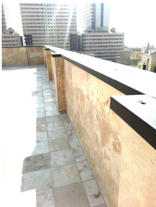
شکل ۱۳ - سمت راست: کوتاه بودن ارتفاع جانپناه بام و عدم اجرای صحیح سنگ در پوش و سمت چپ: اجرای صحیح پشت بندی ها و درپوش جانپناه بام
