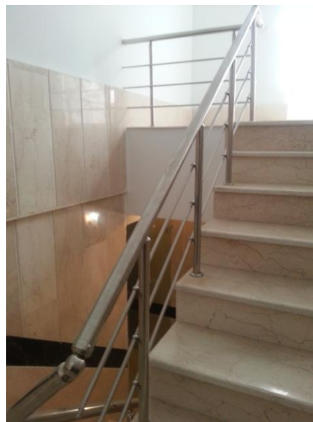
شکل ۲۰- استاندارد نبودن ارتفاع نرده دست انداز یله و فاصله قیدها در خرپشته
