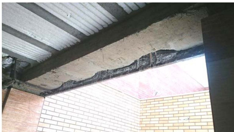
شکل ۸- اجرای نبشی کشی جهت اجرای سازه نگهدارنده نما و عدم توجه به آن در مرحله اسکلت و سقف که موجب تخریب پوتر شده است
