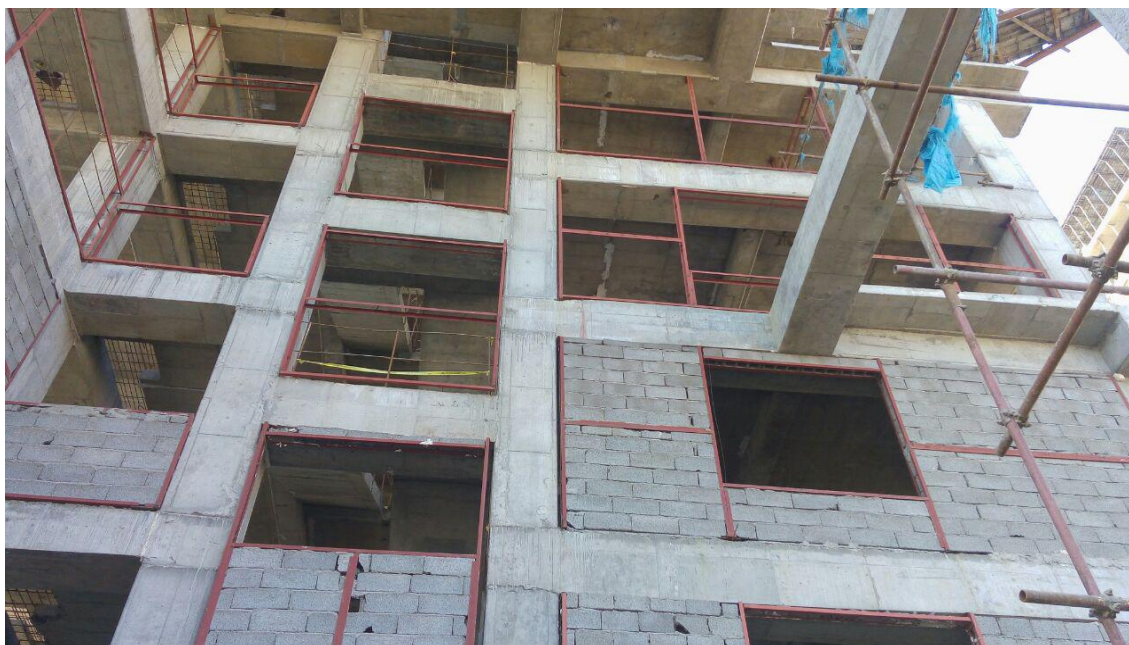
شکل ۵- اجرای وال پست ها جهت اجرای دیوارها
