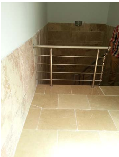
شکل ۲۰- استاندارد نبودن ارتفاع نرده دست انداز یله و فاصله قیدها در خرپشته
