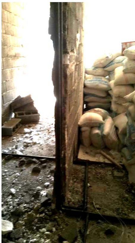
شکل ۶- عدم رعایت ضخامت دیوارهای خارجی و مجاور فضای کنترل نشده مغایرت با مبحث ۱۹
