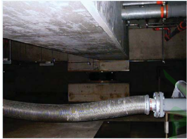
۳-۵ الف- استفاده از اتصالات انعطاف پذیر در محل عبور لوله های تاسیسات از طبقه جداسازی
