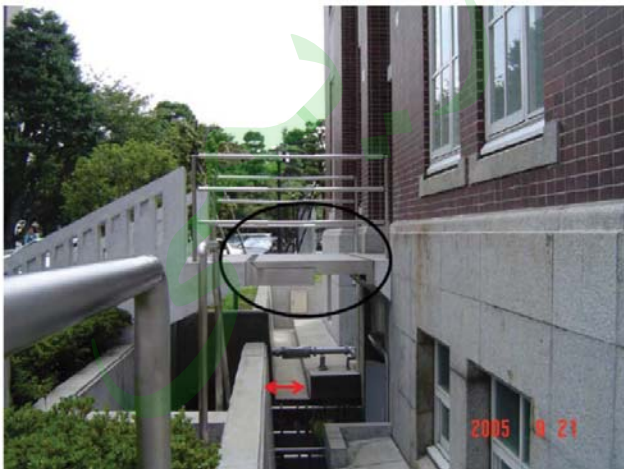
تصویر ۵-۱-ب- ایجاد قابلیت جابجایی جانبی و قائم در محل پل دسترنجس با ایجاد شیار
