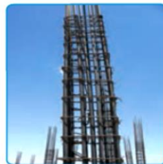
شکل ۱۹-۷- کار گذاشتن میلگردهای انتظار ستون، در فونداسیون
