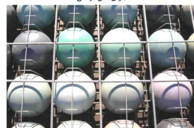
اجرای مش فوقانی
