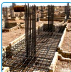
شکل ۱۸-۷- تکمیل میلگردگذاری ستون
