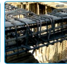
شکل ۷-۲۶- خم میلگردهای اصلی در انتهای محل قرارگیری
