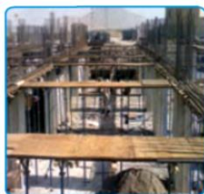
شکل ۷-۲۱- قالب بندی تیرها
