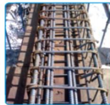
شکل ۷-۲۵- بستن خاموت ها با مفتول
