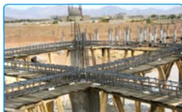
شکل ۷-۲۷- رعایت فاصله پوشش بتنی در کف
