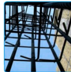
شکل ۱۹-۷- کار گذاشتن میلگردهای انتظار ستون، در فونداسیون
