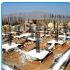
شکل ۱۷-۷- اجرای خاموت و سنج چک
