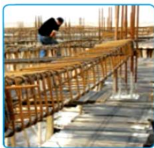
شکل ۷-۲۴- تنظیم فاصله بین خاموت ها
