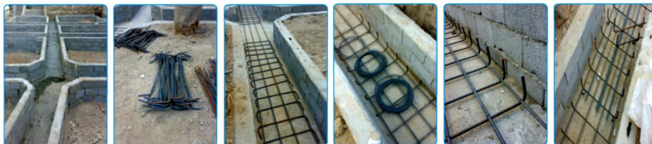
شکل ۶-۷- آماده سازی کف پی
